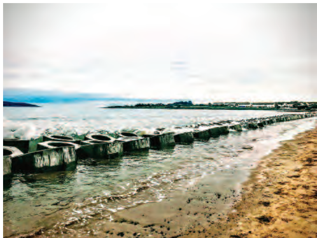
Figiúr 9. Teaghaisí i bPort Rois ar tí titim isteach san fharrage mar gheall ar chreimeadh cósta (ar chlé); Suiteáil €500,000 de bhloic choincréite mar réiteach gearrthéarmach ar chreimeadh cósta i bPortrairie (ar dheis) (Comerford, 2018)
