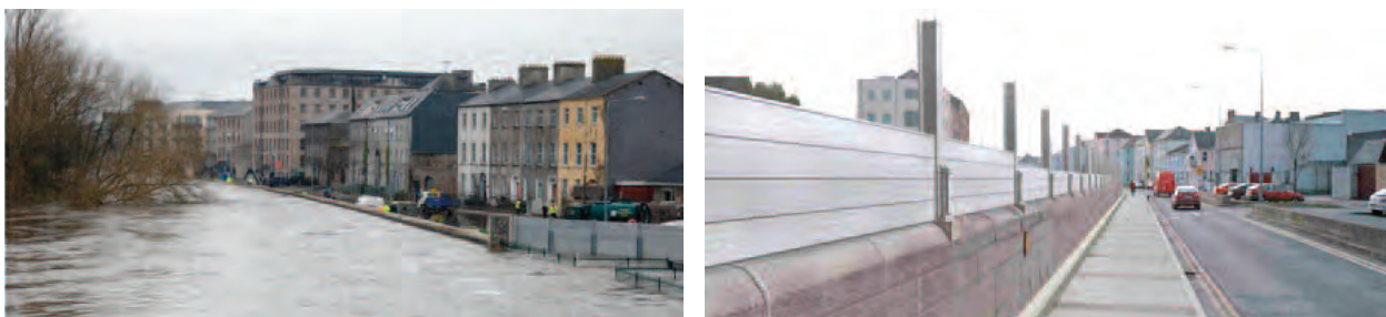
Figiúr 12. Ballaí cosanta ar thuilte a chuir bhac ar an uisce abhann gan dul thar maol tar éis tréimhse fada bháistí troime in 2014 (ar chlé); cosaintí in-díshuite ar féidir iad a ardú sula roimh don tuilte féideartha gus a ísliú le linn amanna ina bhfuil riosca íseal ann ionas nach gcuirfidís isteach ar cuma an bhaile chun féachaint air. Forbraíodh córas rabhaidh ood chun monatóireacht a dhéanamh ar bháisteach sa dobharcheantar chun a chinntiú go bhfuil na cosaintí suiteáilte go hiomlán roimh thuille (ar dheis) (McCarthy, 2015; Mott MacDonald Ireland).
